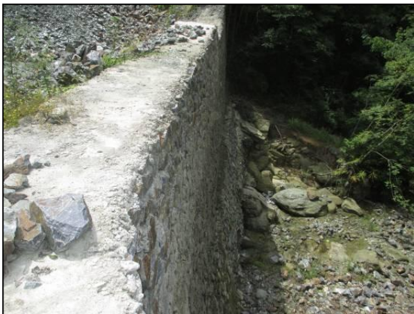
照片 2-8 废石场挡墙 2
