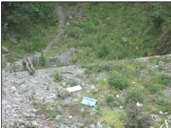
照片 2-7 废石场挡墙 1
