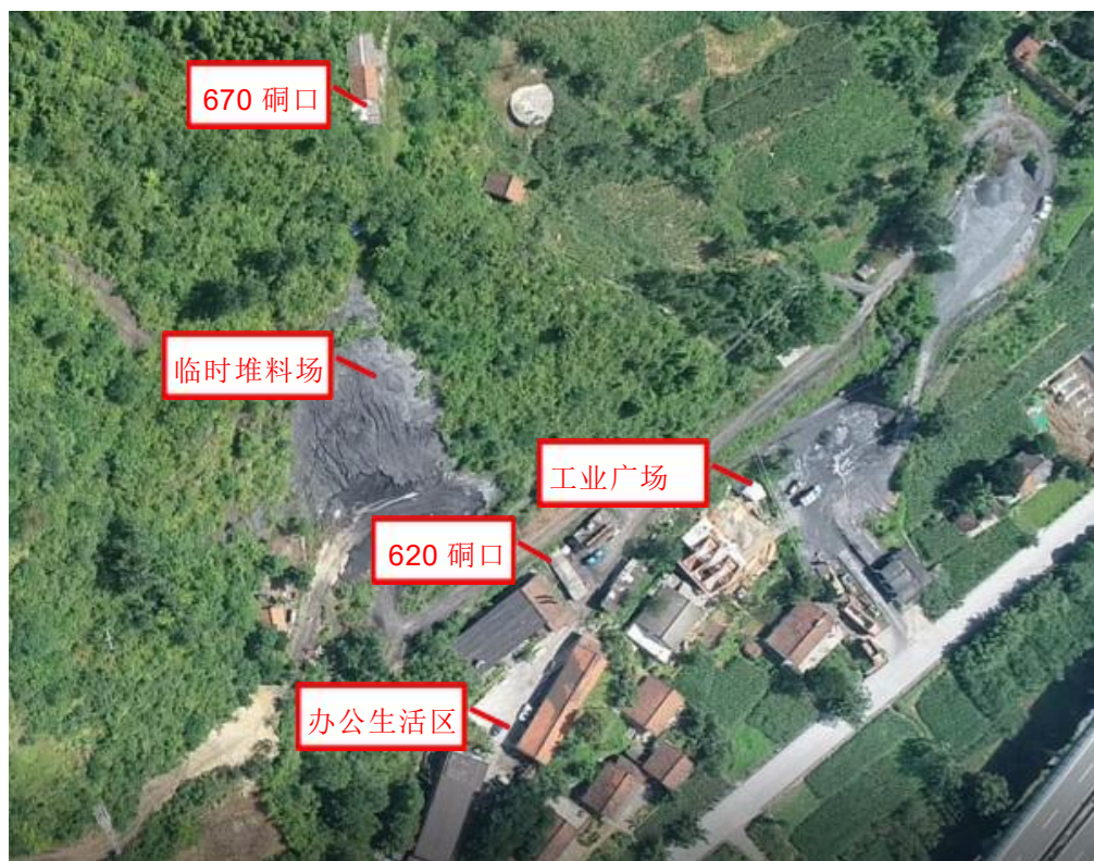
照片1-17为南翼矿区地面设施（航拍）
