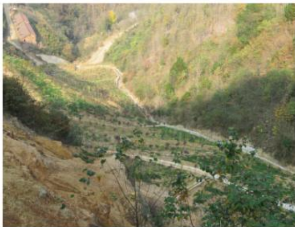
照片 2-29 为渣面绿化及渣堆截排水渠
