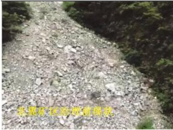
照片2-23为北翼滑坡治理前
