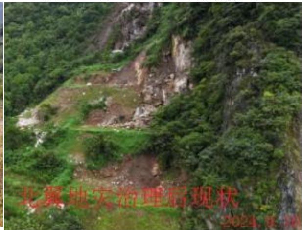
照片2-20为北翼刀背石梁崩塌治理后
