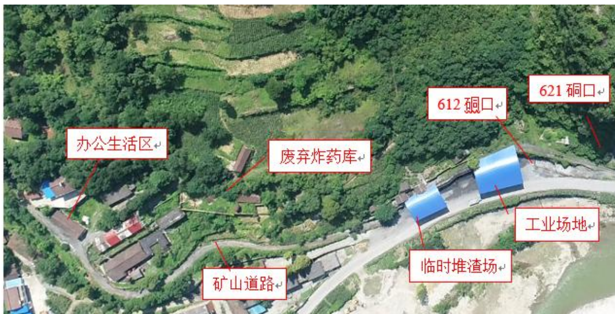
照片1-7为北翼矿区地面设施（航拍）
