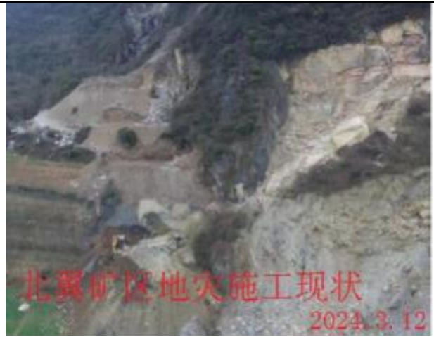
照片2-18为北翼刀背石梁崩塌治理前
