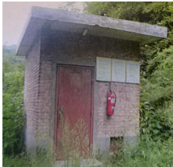
照片1-4为废弃雷管库（镜向340°）
