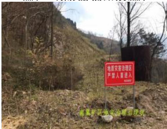
照片2-15为南翼崩塌治理后
