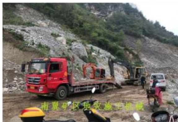
照片 3-3 为南翼崩塌治理中
