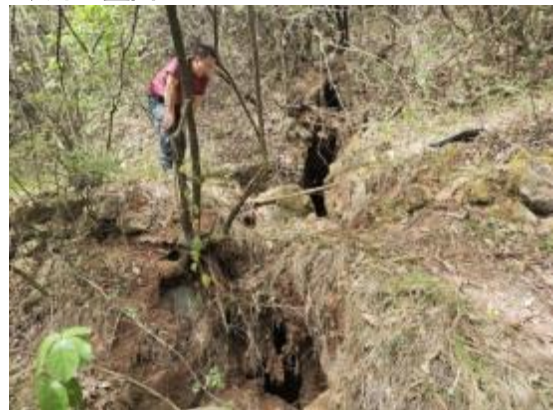
照片3-8为LF2地裂缝（镜像294°）
