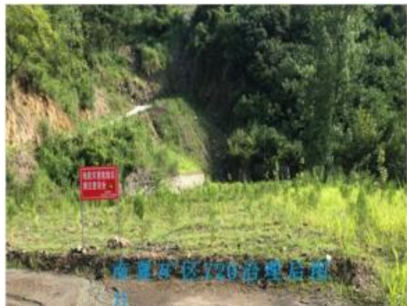
照片2-16为南翼崩塌治理后
