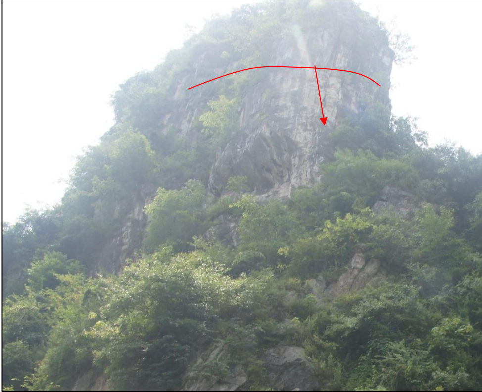
照片 3-6 为北翼崩塌隐患 B2（镜向 100°）
