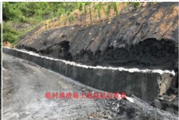
照片2-22为临时堆渣场治理后
