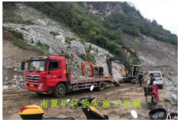
照片2-14为南翼崩塌治理中
