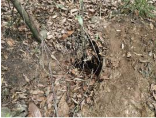
照片3-9为LF3地裂缝（镜像295°）
