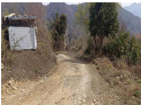
照片 1-9 矿区临时道路（镜向 72°）
