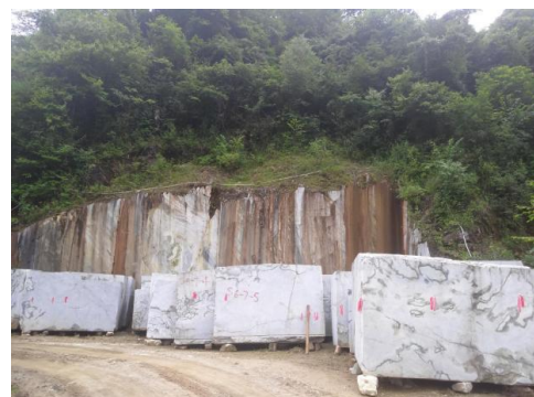
照片 3-10 2 号采场挖损林地（镜像 300°）
