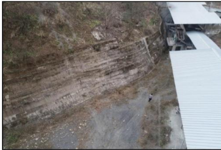
照片 2-7 滑坡治理砌筑浆砌石挡墙（航拍正射）
