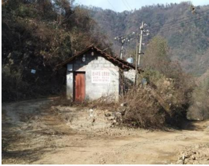
照片 1-15 变电站 1（镜向 349°）
