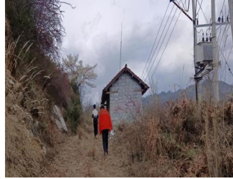
照片 1-16 变电站 2（镜向 338°）
