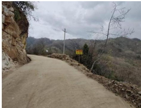
照片 1-10 矿区进场道路（镜向 339°）
