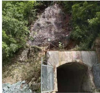
图 2-20 BT2 安装主动防护网
