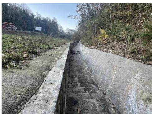
图 2-39 矿区废石场修建排洪沟
