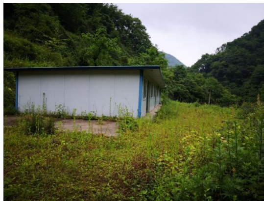
照片 1-11 临时板房（已拆除）（镜向 352°）
