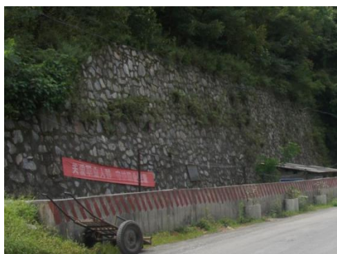
照片 2-15 北翼场地挡墙（镜向 26°）
