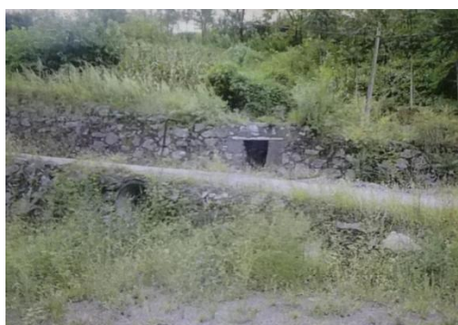
照片 2-16 北翼道路区挡墙（镜向 28°）
