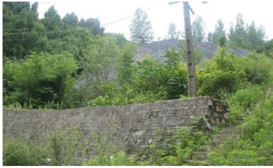
照片 2-18 弃渣场挡墙（镜向 210°）
