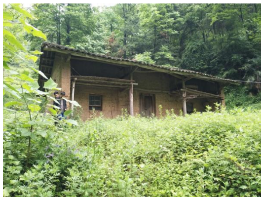
照片 2-11 废弃房屋（镜向 190°）
