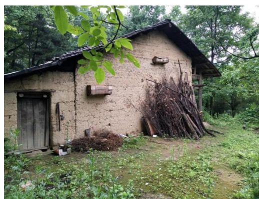
照片 2-12 废弃房屋（镜向 286°）
