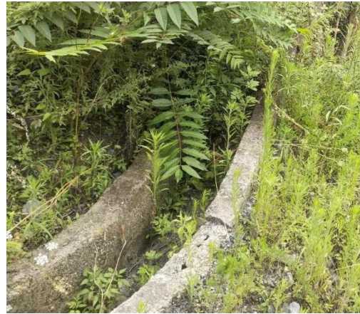
照片 2-19 坡角排水渠（镜向 186°）
