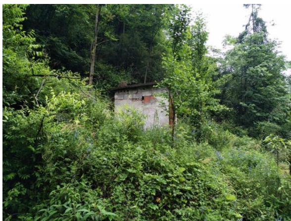
照片 1-9 雷管库（镜向 293°）
