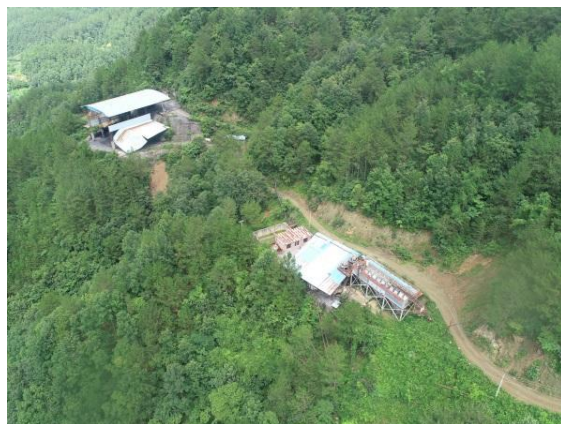
照片 1-4 精选车间及精粉站（镜向 290°）
