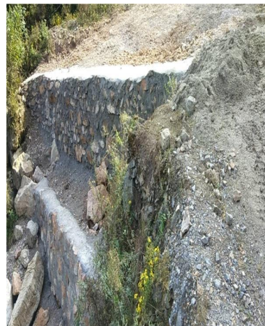
照片 1-4 PD404（1020m）硐口渣堆（Z2） 废渣堆已建挡墙
