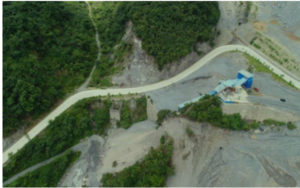
照片 2-31 修建的拦渣墙、截排水沟
