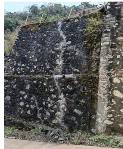
照片 1-2 BT2 挡墙裂缝灌浆加固
