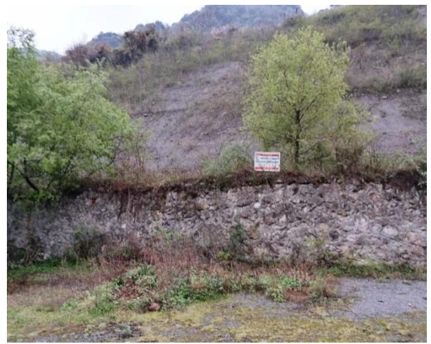
照片 2-14 Z3 废渣堆已建挡墙
