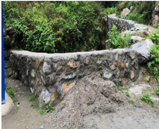
照片 2-15 Z1 废渣堆下方已建挡墙
