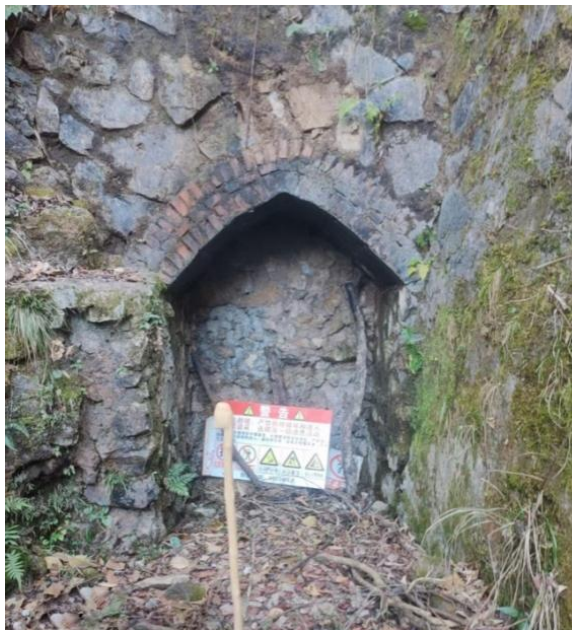
照片 2-24 封堵 PD502 矿硐口（镜向 350°）
