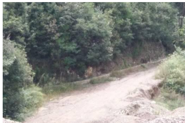
照 1-19 田湾矿山自建道路
