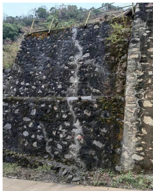
照片 2-20 BT2 崩塌隐患挡墙裂缝灌浆加固
