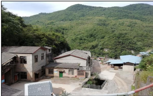
照片 1-11 选矿厂房设施
