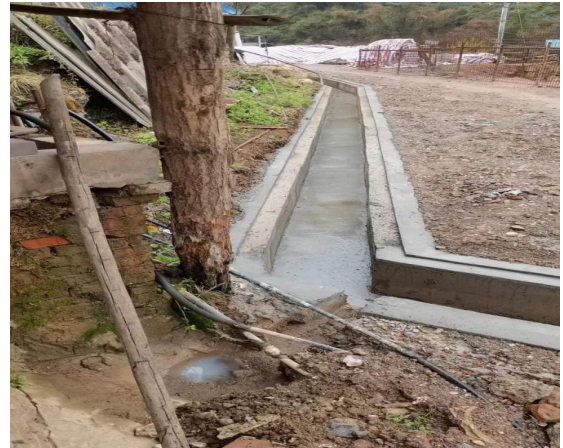
照片 2-16 Z3 废渣堆后缘已建排水渠
