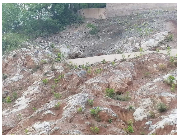
照片 1-15 郑家沟临时堆矿场（K1）
