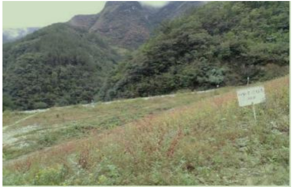
照片 2-29 大沟尾矿库堆积坝面复绿
