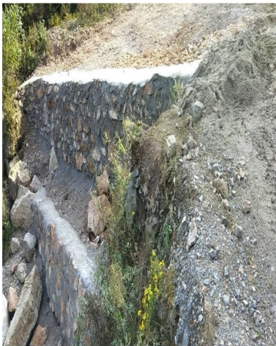
照片 2-13 Z2 废渣堆已建挡墙
