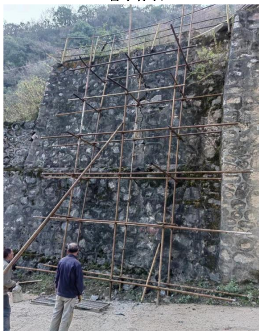
照片 2-19 BT2 崩塌隐患挡墙裂缝灌浆加固
