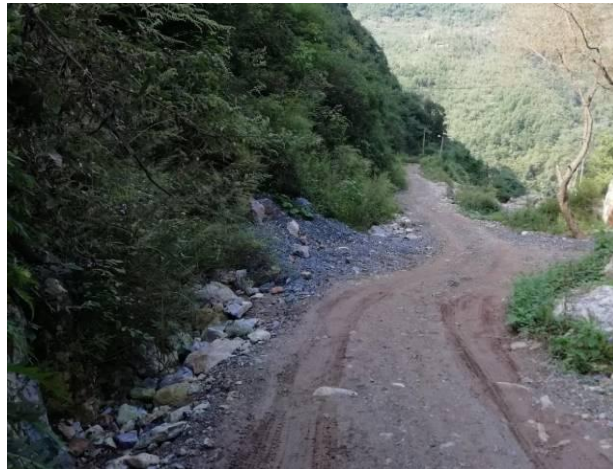
照片 2-12 郑家沟农村道路
