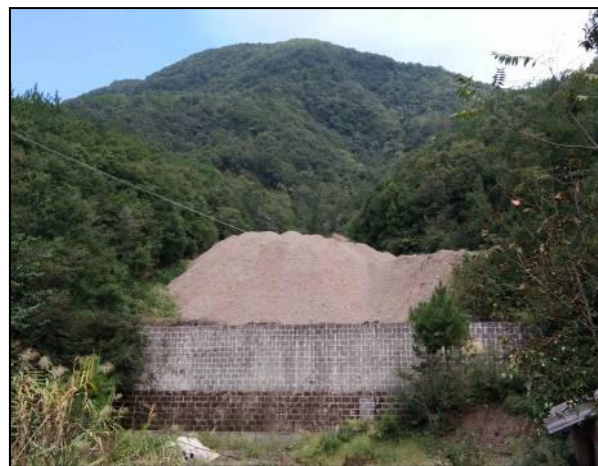
照片 1-17 田湾堆渣场拦渣坝
