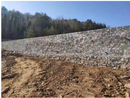
照片 2-9 临时排土场挡土墙
