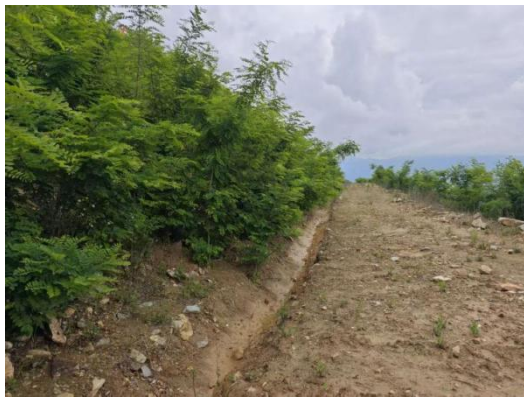
照片 2-13 +1150m 平台截排水渠现状
