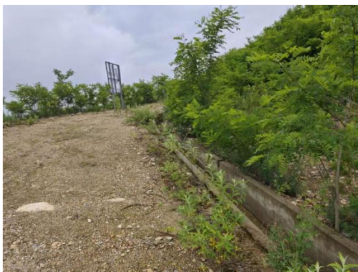
照片 2-12 +1170m 平台修建截排水渠
