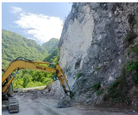
照片 2-9 BT1 隐患清除坡面危岩体
