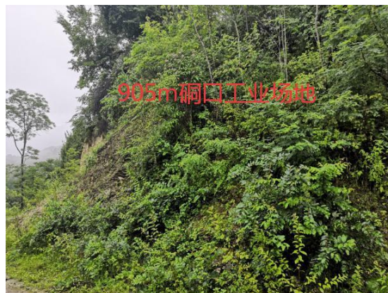
照片 1-5 拟建 905 硐口工业场地
