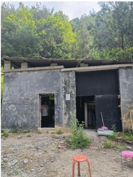
照片 1-3 提升机房 (2026. 7. 10)
