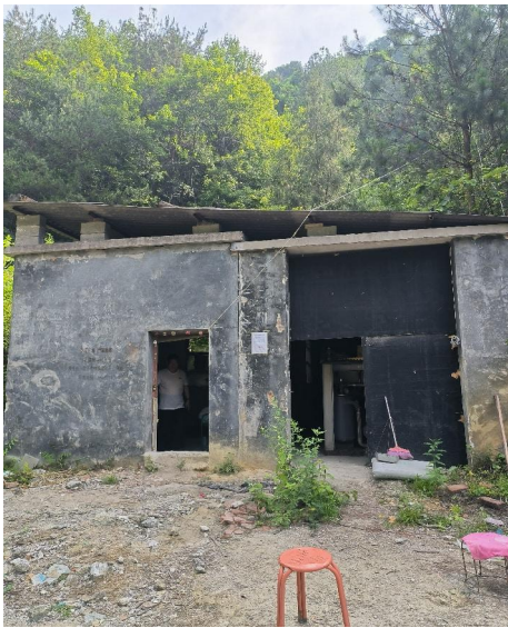
照片 3-3 提升机房 (2026. 7. 10)
