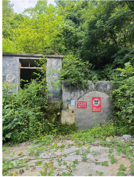
照片 3-2 副井和风机房 (2026. 7. 10)
