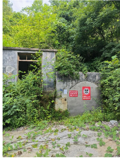
照片 1-2 副井和风机房 (2026. 7. 10)
