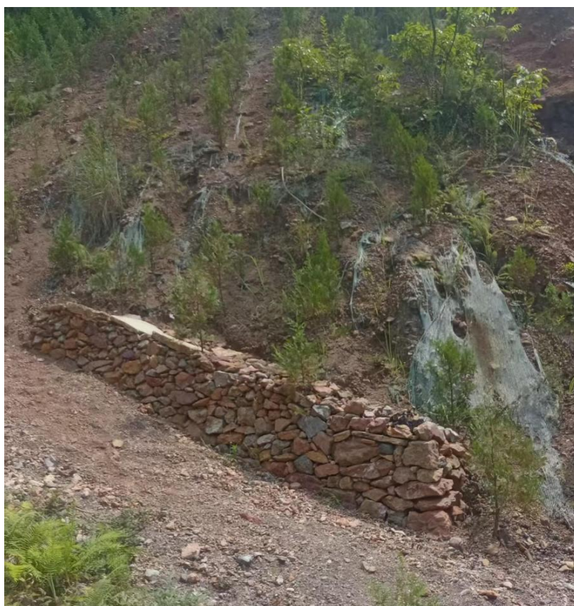
照片 3-6 Z2 废渣堆治理挡墙及土地复垦
