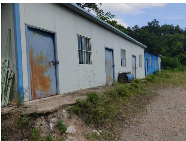
照片 1-12 工业场地 2 空压机房
