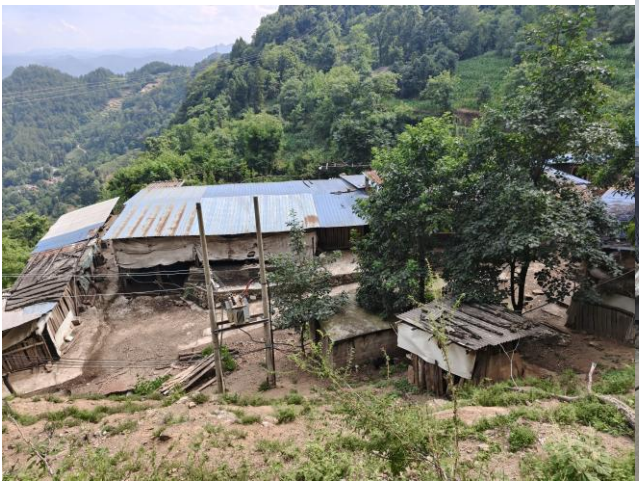
照片 1-4 工业场地 1 局部俯视图
