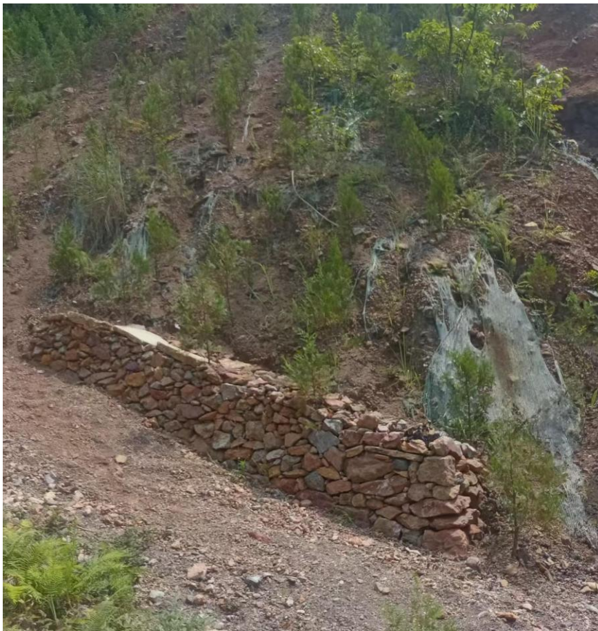
照片 1-19 Z2 废渣堆治理挡墙及土地复垦
