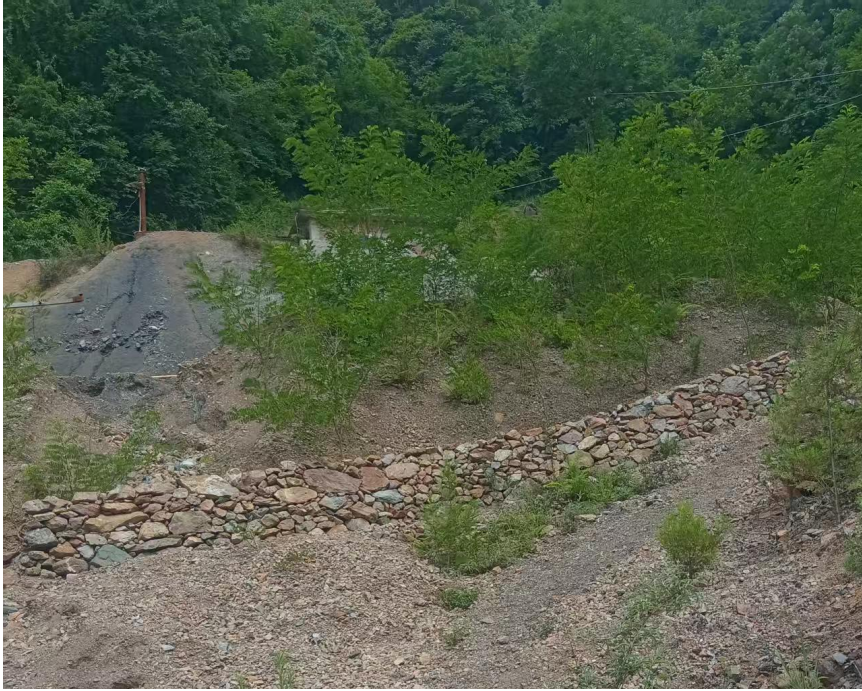
照片 1-18 Z1 废渣堆治理挡墙及土地复垦
