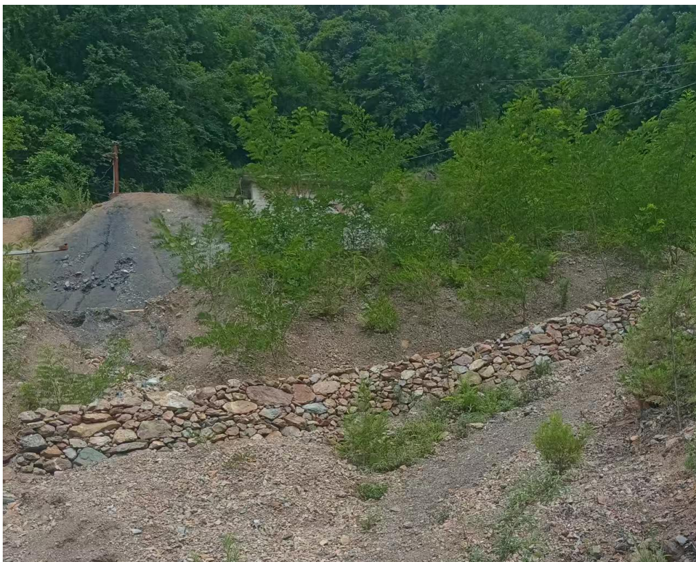
照片 3-5 Z1 废渣堆治理挡墙及土地复垦
