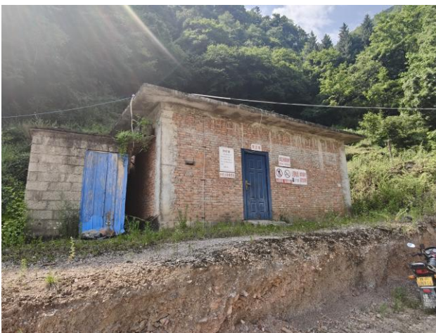
照片 1-10 工业场地 2 警卫室
