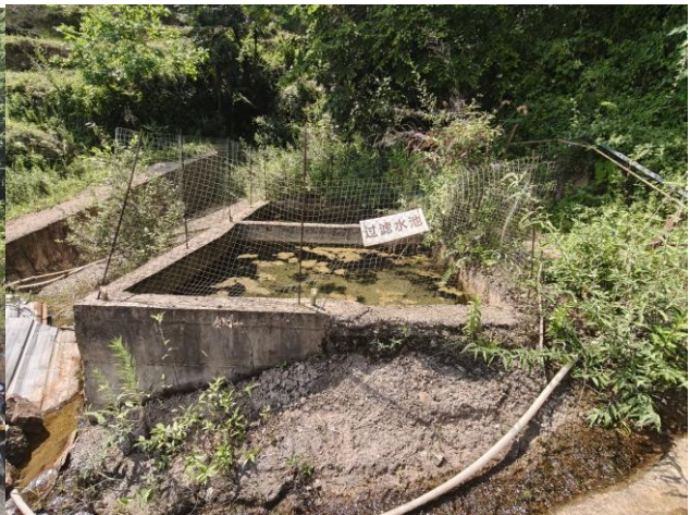
照片 1-11 工业场地 2 过滤水池
